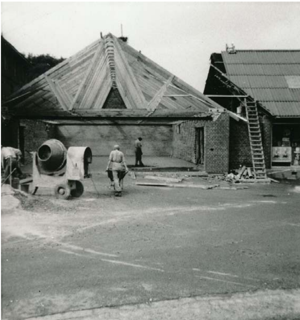
Købmandsforretningen ombygges i 1967.
