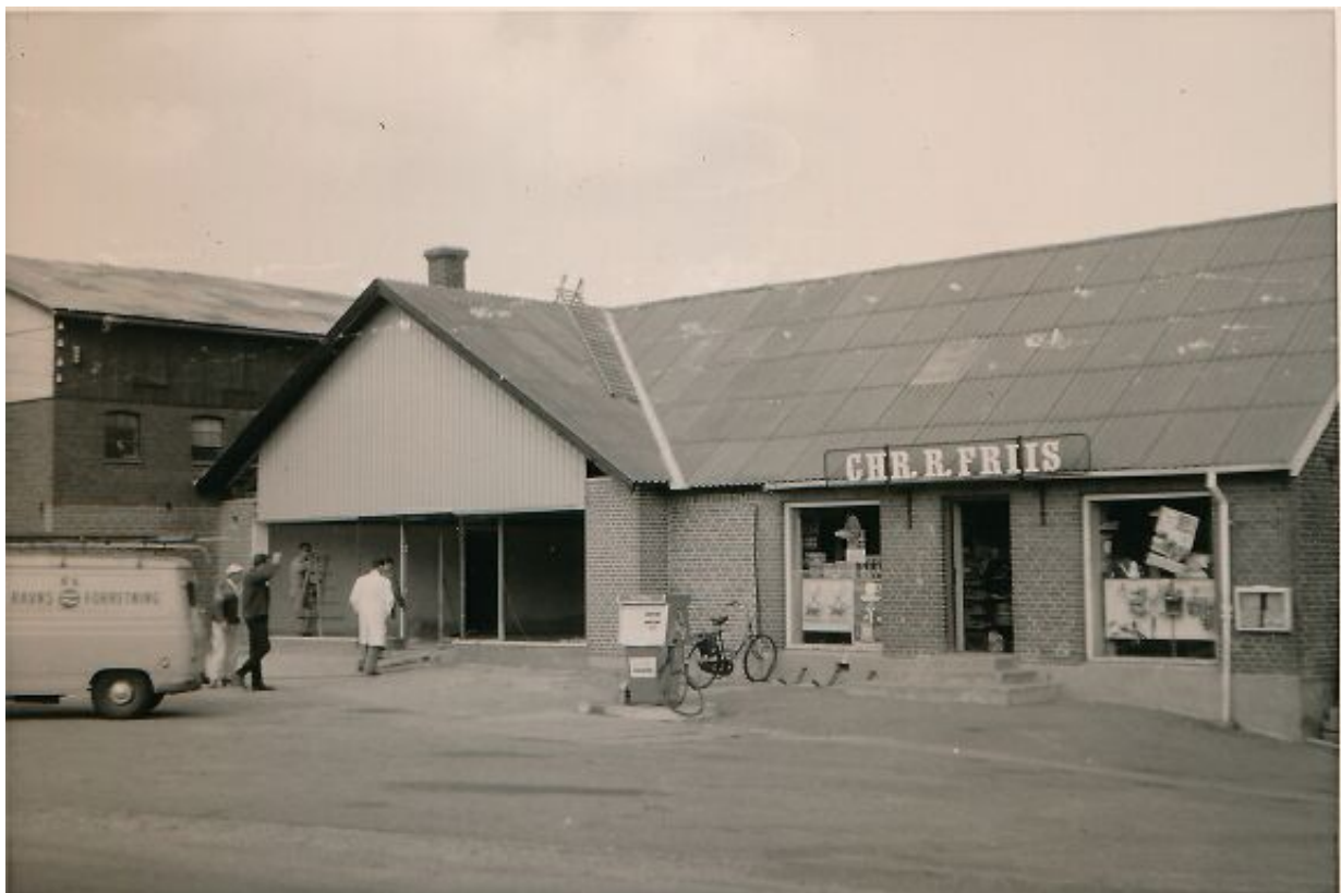
Købmandsforretningen ombygges i 1967.
