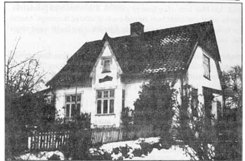
Hjulhuset. Gl. Skanderborgvej 103.
